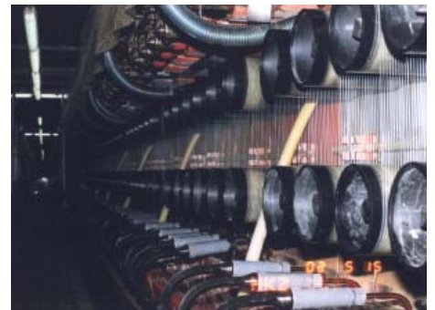
Abbildung 2 HKZ-Spinnmaschine einer Viskoseanlage.
